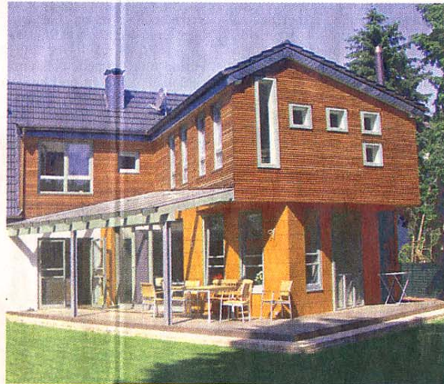
In der Neusser Bolssiedlung ist aus einem alten Haus durch die Erweiterung mit Glasdach und Holzfassade ein moderner Komplex entstanden. Er öffnet am „Tag der Architektur“.
